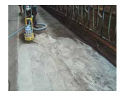
c) extrem abgenutzter Futtertisch Bei stark abgenutzten oder unebenen Futtertischen ("Waschbetonplatten-Optik") lohnt sich der Einsatz einer Betonschleifmaschine, um eine gleichmäßige Bodenstruktur und geringe Verbrauchsmengen
