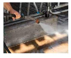
**b) gebrauchter Futtertisch** Reinigen des Untergrundes mittels Hochdruckreiniger und Dreckfräse.
