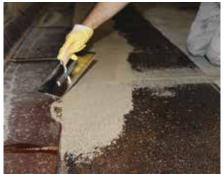
Sehr stark beschädigte Böden sind zudem vor der Beschichtung mit Basic mit **easy-Fill** vorzuspachteln. Das schafft eine ebene Oberfläche und spart Material bzw. Schleifarbeiten. Dazu Mineralmasse mit Harz und Härter im Eimer anrühren. Die Masse mit Spachtel und Glättkelle verarbeiten. **Für eine gute Verdichtung fest anklopfen!**
