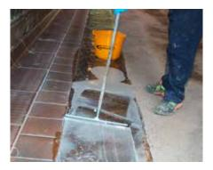
Breiartige Mischung aufgießen und mit Gummirakel verteilen. Schön glatt ziehen, damit keine Kiesel mehr hochstehen.
