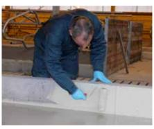
Betonrückwände an Futtertischen und neuen Silowänden mittels PowerGrip grundieren und trocknen lassen. Danach mit Rolle satt mit Top-F beschichten.
