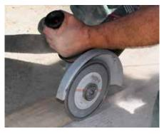
Als Abschlusskante für den zu beschichtenden Futtertisch mit der Diamantscheibe eine Begrenzungsnut von ca. 2–3 mm Tiefe einschneiden, um einen perfekten Abschluss zur Futtertenne zu erzielen. Nut vor Reinigung und Schleifen anfertigen.
