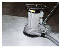
a) neuer Futtertisch Um bei neuen Futtertischen einen offenporigen Untergrund zu erhalten, müssen Zementschleimschichten des Betons mittels Schleifmaschine oder Strahlarbeiten vollständig entfernt werden. Schleifrückstände sind restlos zu entfernen.
