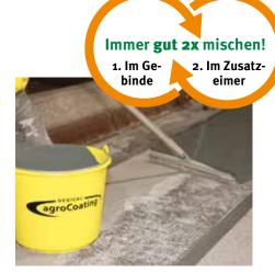
Verteilen von Basic mit Glättkelle oder Gummirakel. Anschließend mit kurzfloriger Rolle abrollen.
