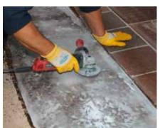
Nach ca. 6–8 Stunden ist die Füllung grifffest. Fläche auf Störpunkte kontrollieren und ggfs. abschleifen, wo nötig. Dann final mit **Basic** beschichten.
