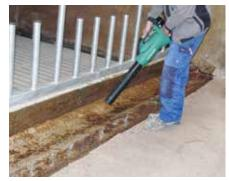
Feine Staubpartikel lassen sich am besten durch Abblasen mittels Kompressor oder Laubbläser entfernen. Idealerweise mit Industriesauger absaugen.
