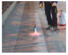
Die Fläche anschließend abflämmen und mit einem Stahlbesen sauber abkehren!
