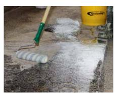
Der Untergrund ist vor der weiteren Beschichtung mit **PowerGrip** zu grundieren, damit eine optimale Haftbrücke geschaffen wird. Dazu die 2 Komponenten von **PowerGrip** homogen mischen, in frischen Behälter umfüllen, erneut mischen und anschließend mit einer Rolle auftragen. **Grundierung anziehen lassen.**
