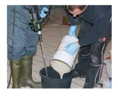
Homogenes Mischen der 2 Komponenten von Top-F und Umfüllung in einen anderen Behälter, nochmals durchmischen. Langsam rühren bei max. 300 U/min.
